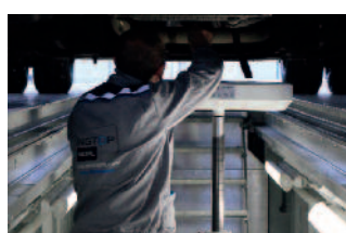
21. Exemple des travaux sur la fosse - collecte des huiles usagées
