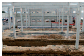
13. Bétonnage de fosse de maintenance
