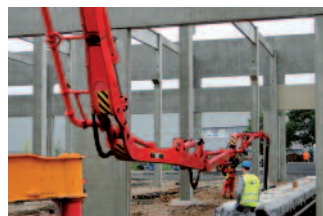
14. Bétonnage de fosse de maintenance
