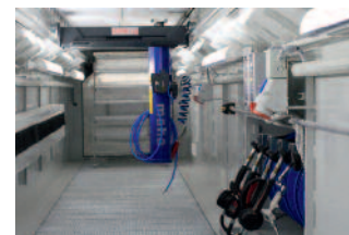
17. Fosse de maintenance pour collecter des huiles usagées inclus les bâtis pour les nouveaux huiles
