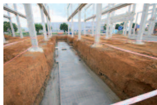
7. Plaques de fondation en béton préparées
