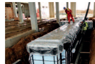
12. Bardage et bétonnage de fosse de maintenance
