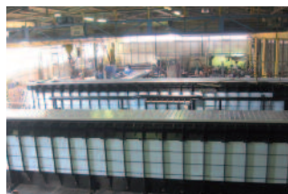
3. Fabrication des fosses de maintenance
