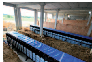
10. Fosses de maintenance après le placement sur la plaque de fondation
