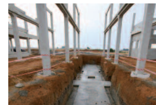
6. Plaques de fondation en béton préparées
