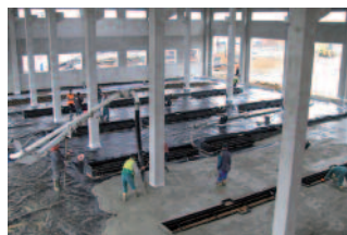
15. Bétonnage de fosse de maintenance
