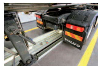
23. Fosses de maintenance en pratique
