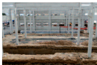
13. Bétonnage de fosse de maintenance
