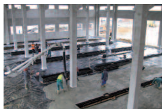
15. Bétonnage de fosse de maintenance
