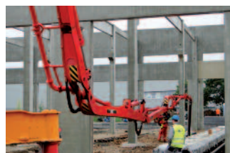
14. Bétonnage de fosse de maintenance
