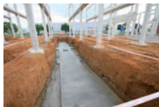
7. Plaques de fondation en béton préparées
